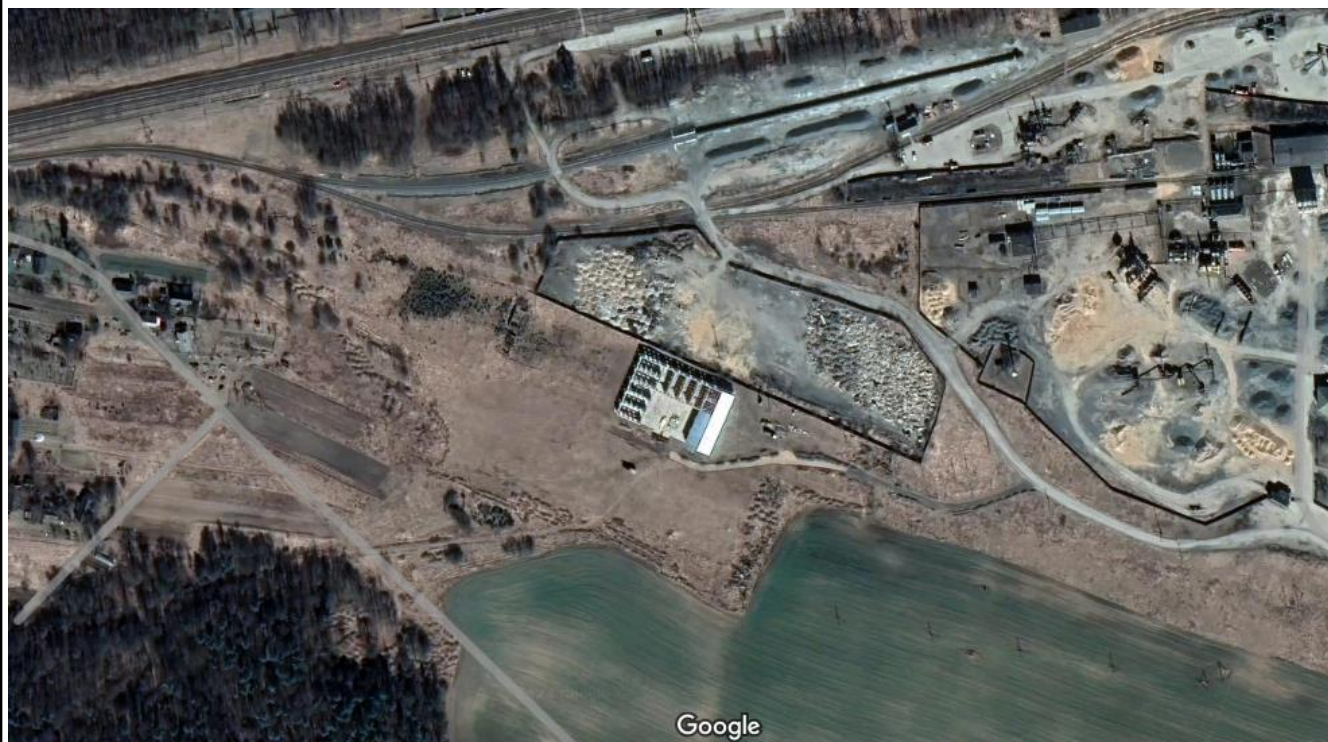
Рисунок 4 Состояние площадки размещения хозяйственной деятельности
